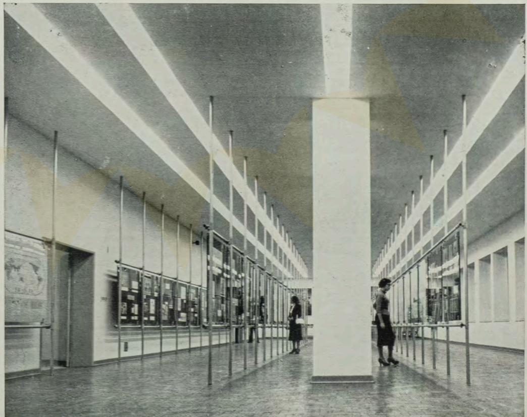
Arquiteto Lina Bo Bardi: Exposição didática (1947). As pranchas são colocadas entre duas folhas de cristal temperado Vis de 1,20 x 1,20 m., o que permite a visão dos dois lados. Os quadros de cristal são presos por meio de pequenas mordaças com garnição de borracha e suspensos numa armação de tubos de alumínio fixos entre o teto e o pavimento.
