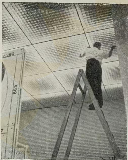
O teto é trabalhado em estrutura celular de lâminas metálicas esmaltadas de branco, o que permite uma difusão uniforme de luz, sem projeção irregular de sombra; as subdivisões em setores completamente dobráveis sobre si mesmos, permitem com facilidade os trabalhos de inspecção e limpeza. Vista parcial da pinacoteca; as paredes da exposição são montadas sobre pés de tubo de ferro e mantidos fixos por meio de fios de aço tesos com esticadores, de maneira
